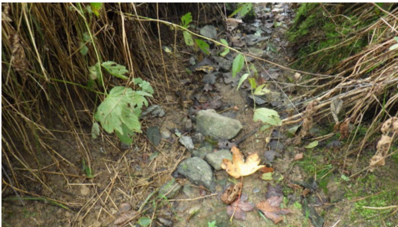
Abb. 19: Tief eingeschnittene Grabensohle mit erodierten Uferseiten
